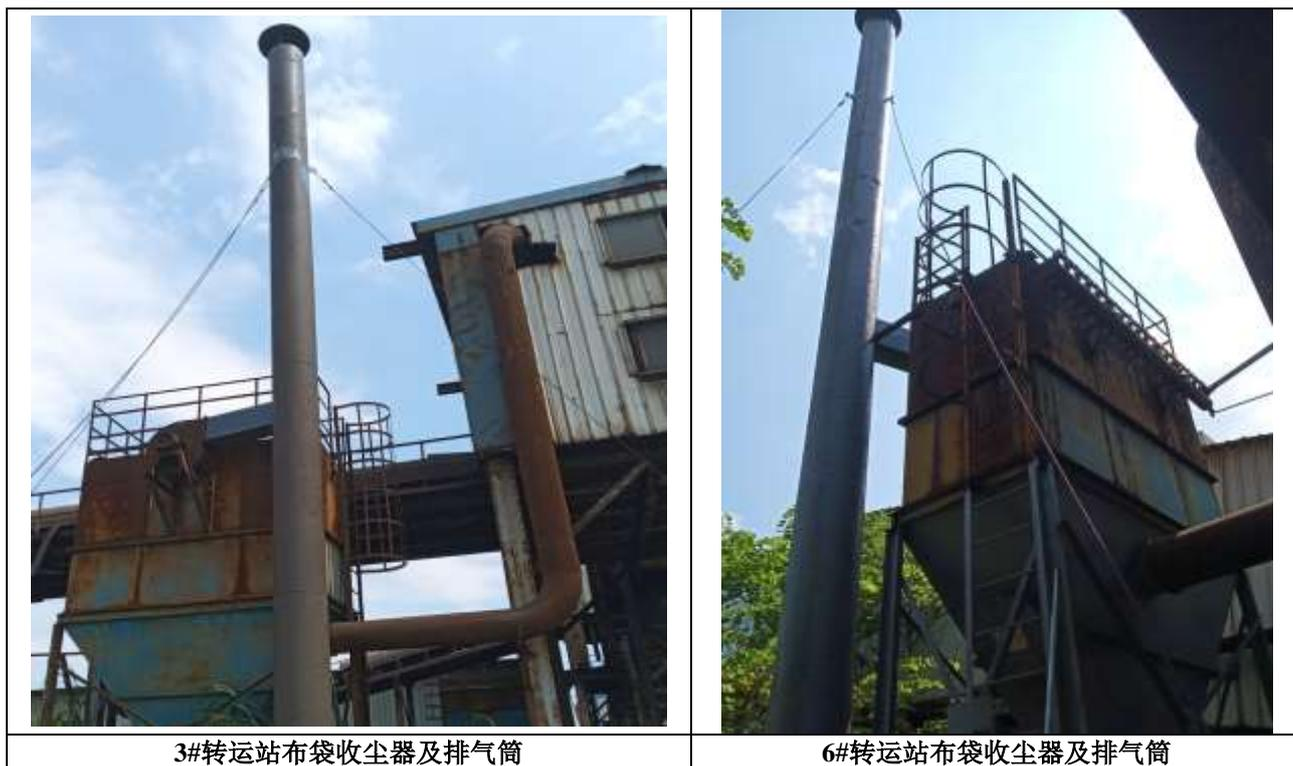
图 3.1-7 皮带输送系统除尘设施现状图
