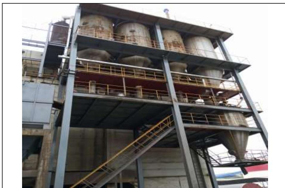
图 3.1-13 矿热炉烟尘仓密闭存储现场图
