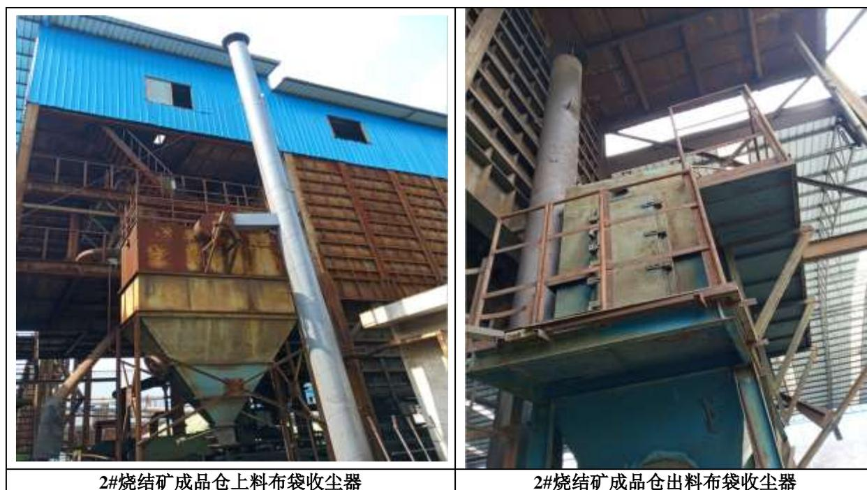
图 3.1-8 原料皮带输送收尘系统除尘设施现状图
